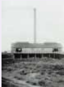
塵芥焼却場 (北1東12) (昭10.7) 豊平川尻川地帯に、工費13万円で竣工
