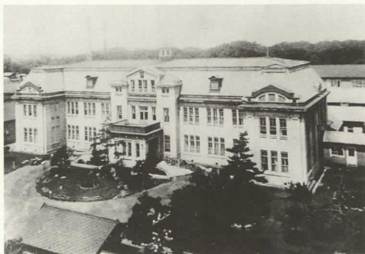
大正12年に施工した初代市立札幌病院本館
