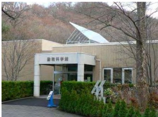
動物科学館に設置している太陽光発電(出力5kw) (特定非営利活動法人 ひまわり種の会設置・所有)
