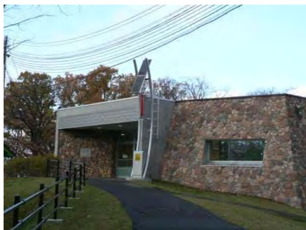
サル山展望レストハウスに設置している 風力と太陽光発電設備
