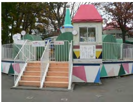
老朽化した遊具 平日は一部しか営業していない
