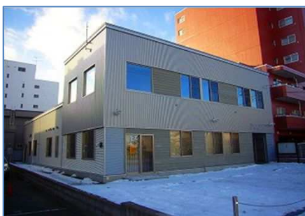
平岸まちづくりセンター・地区会館
