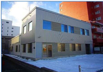
平岸まちづくりセンター・地区会館の例
