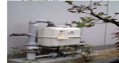
ガス変換機接続口
