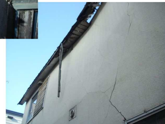
▼建築資材の落下・飛散の おそれのある空き家の例
