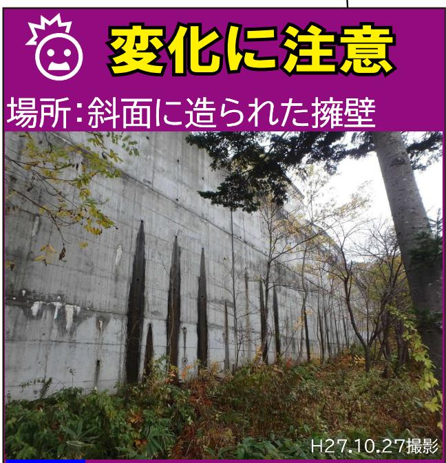
**普段:**擁壁の水抜き孔から、湧き水が流れている。
