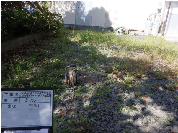
観測孔蓋 近景
