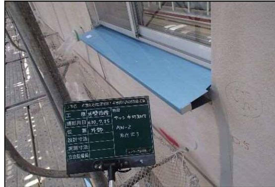
図 3-1-4 外窓水切り交換状況
