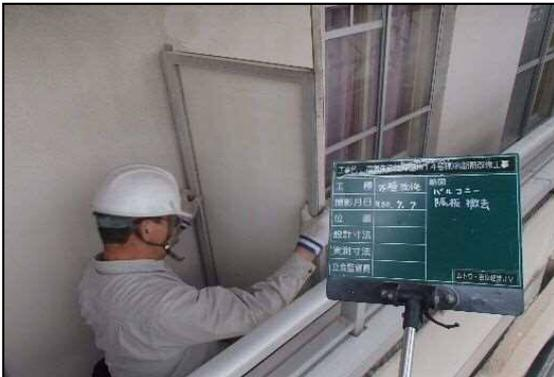
図 3-1-3 隔壁撤去状況
