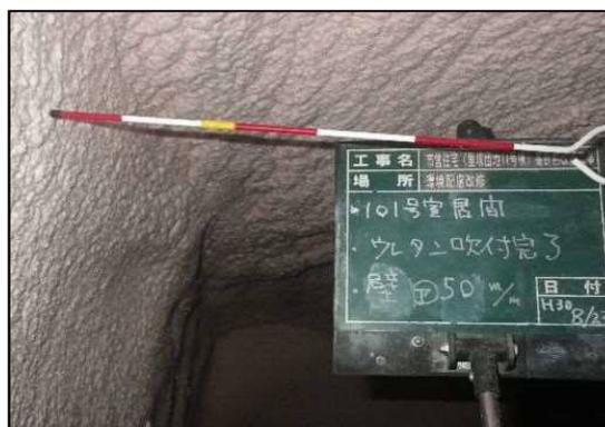
図 3-1-8 立上り部分 50mm 吹付状況(②)
