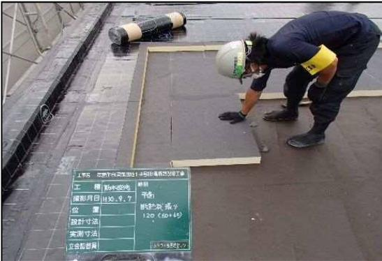
図 3-1-1 断熱材敷設状況(③)
