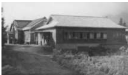
手稲町役場庁舎(奥)と 竣工時の議事堂(手前) 〈1953年〉
