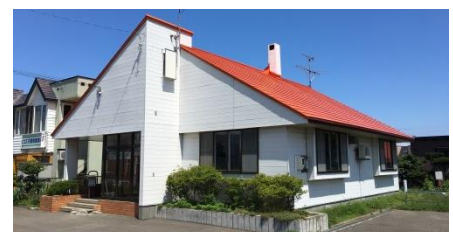
※工事前の写真です
