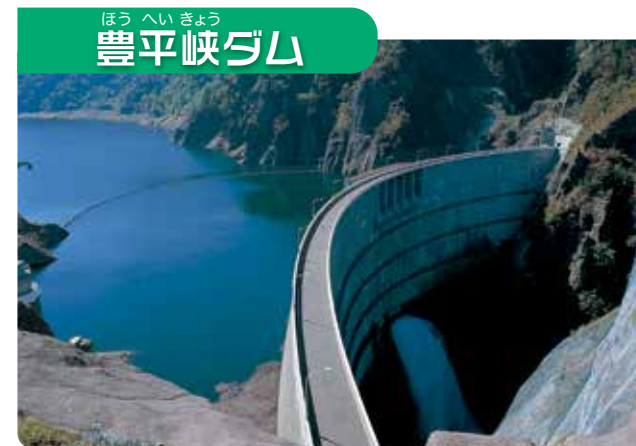
豊平川の上流につくられたダムで、1日あたり約53万立方メートル(学校のプール1,500杯分)の水源を確保しています。
