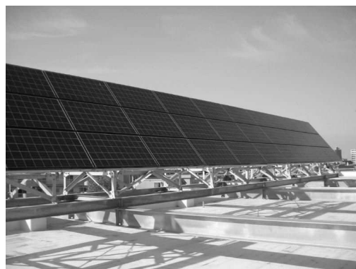
配水センターの太陽光発電設備
