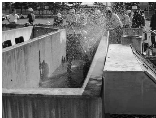
漏水修理実習
