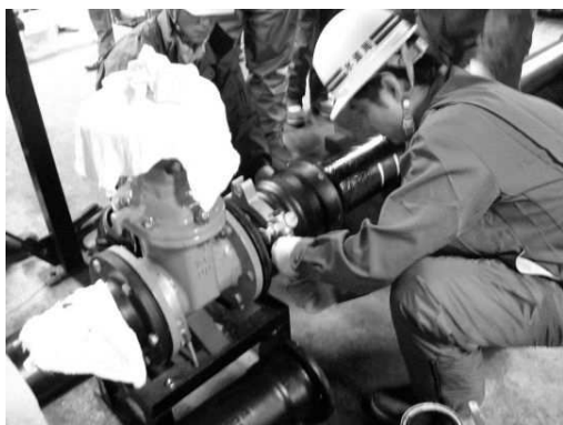
配水管接合実習
