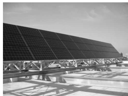
配水センターの太陽光発電設備
