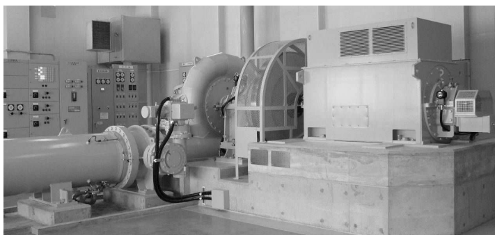
藻岩浄水場の水力発電設備
