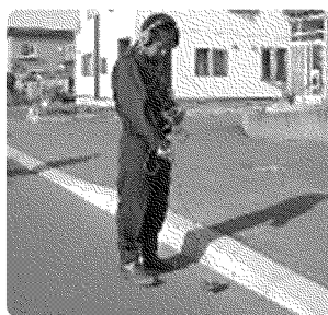
漏水探知器による調査
