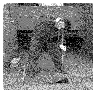
水道メーターの音聴調査
