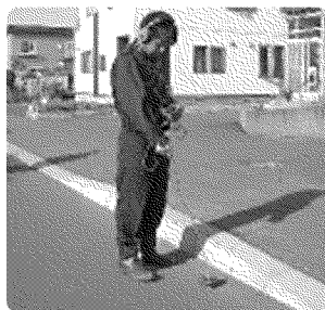
漏水探知器による調査
