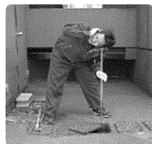
水道メーターの音聴調査
