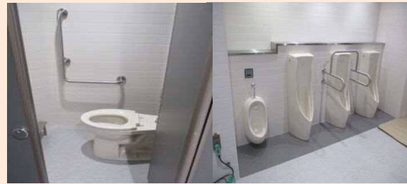
〈 改修後のトイレ 〉
