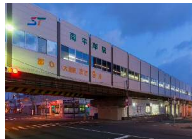
《耐震改修後の南平岸駅》
