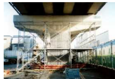
< 橋脚の補強工事 >
