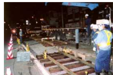
< 軌道改良工事 >
