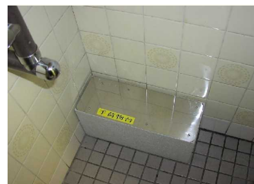
<職員手作りのトイレ荷物台>
