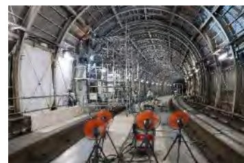
南北線シェルター工事の様子
