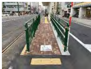
東本願寺前停留場（外回り） 改修後 スロープ
