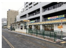
東本願寺前停留場 工事後
