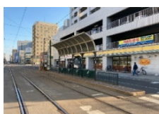
東本願寺前停留場 工事前
