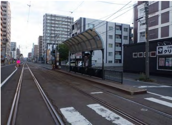
工事前 外回り停留場
