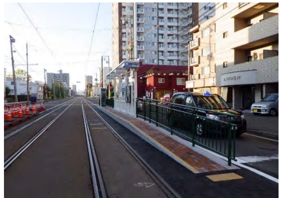
工事後 内回り停留場
