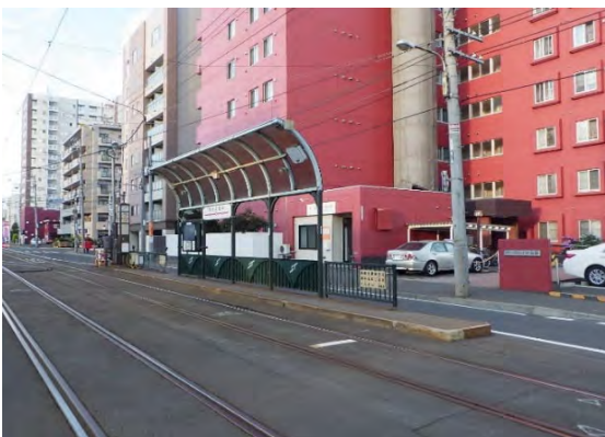
工事前 内回り停留場
