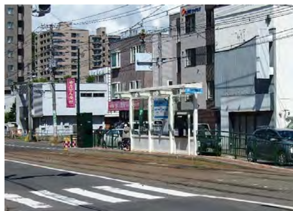
工事後 内回り停留場
