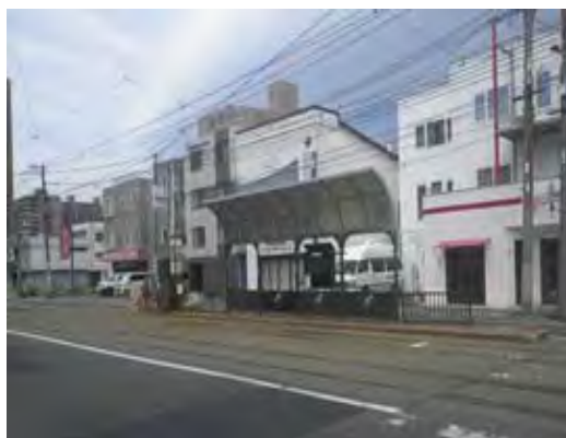
工事前 内回り停留場
