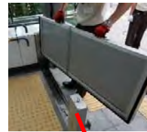
大通駅 止水板
