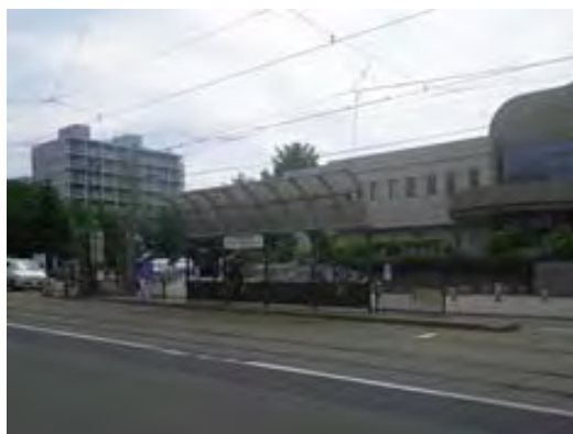
工事前 外回り停留場
