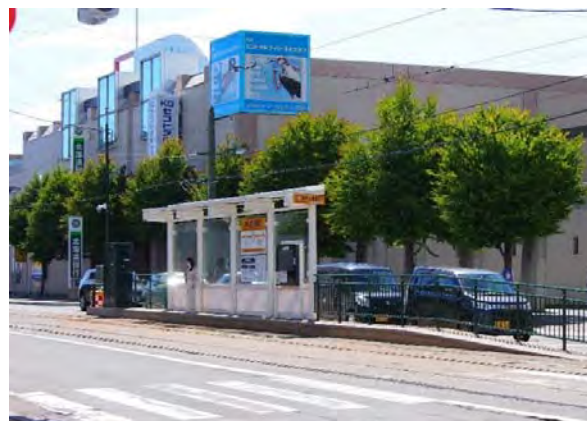
工事後 外回り停留場
