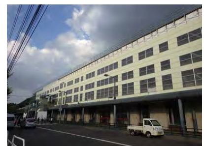
真駒内駅 耐震工事の様子
