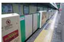
南北線可動式ホーム柵
