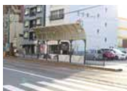
東本願寺前停留場(内回り) 改修前
