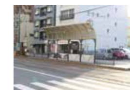
東本願寺前停留場(内回り) 改修前
