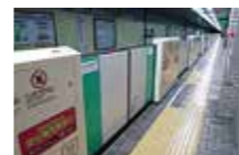
南北線可動式ホーム柵
