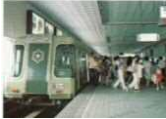
1971年 地下鉄南北線 北24条駅と真駒内駅の間 の12.1km
