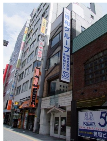
札幌中心部のビルの状況
