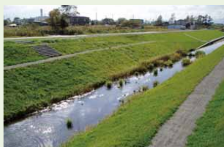
▲大雨による増水に対応するために改修された雁来川
