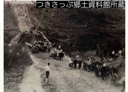
アンパン道路整備の様子▶
