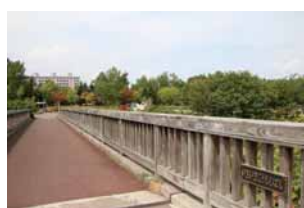
▲いきいき公園橋
