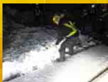
↑夜間の除雪作業
