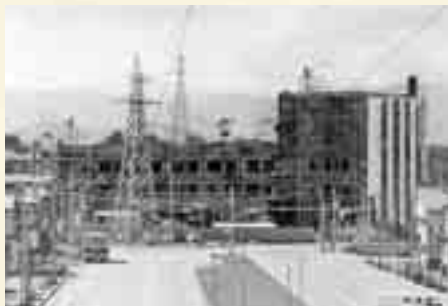
▲建設中の現・豊平区役所（昭和48年）
