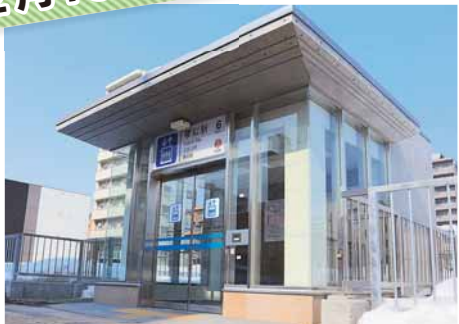
地下鉄駅構内直結のエレベーター
