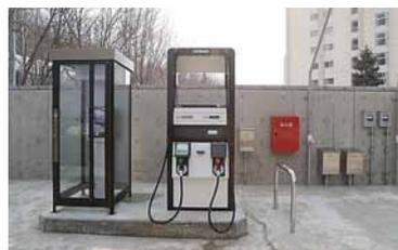
▲自家給油設備。緊急車両に給油するガソリンと軽油を各1万ℓ貯蔵。
