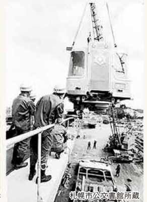
▲設置作業中の地下鉄車両
