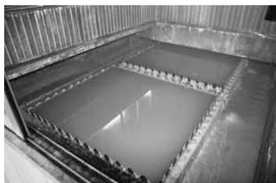
施設に流れてきた下水は、ごみや砂が取り除かれた後、最初沈殿池へ。水より重い汚れは底にたまるようになっています。
