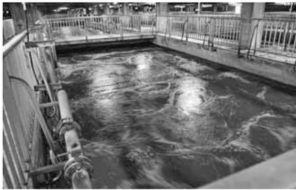
反応タンクでは、微生物を多く含んだ活性汚泥と呼ばれる泥状のものが加えられます。すると、水の中の有機物は微生物の栄養として吸収され、活性汚泥と一体化。沈殿しやすい塊になります。
