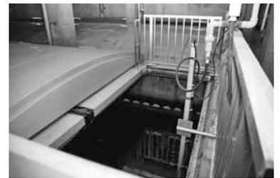
反応タンクでできた塊はここで底に沈み、きれいになった上澄みの水は川に放流されます。定期的な水質を検査して、環境の保全に努めています。
