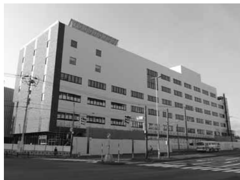
建設中の白石区複合庁舎
