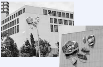
白石清掃工場壁面（東米里2170）
