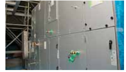
▲機械室の様子
