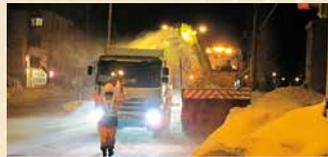
雪をダンプカーに載せて、雪堆積場に運びます。除雪よりも機械や人が必要で、時間も費用もかかる作業です。
