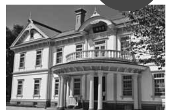
改修前の豊平館
