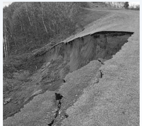
平成22年12月の清田区を震源とした直下型地震では、震度4~5弱の大きな揺れに襲われ、崖崩れや建物への被害が発生しました。
