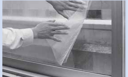
▲窓には断熱シート
