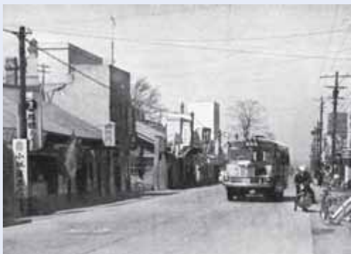
昭和30年頃の月寒中央商店街の様子
