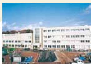
建築中の 総合庁舎
