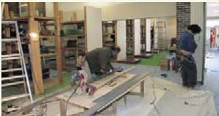
▶大掛かりな改修工事
