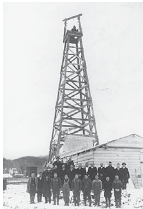
▲油沢の試掘現場(昭和9年)
