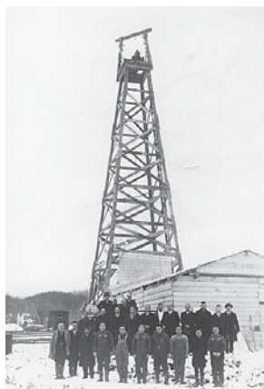
▲油沢の試掘現場(昭和9年)
