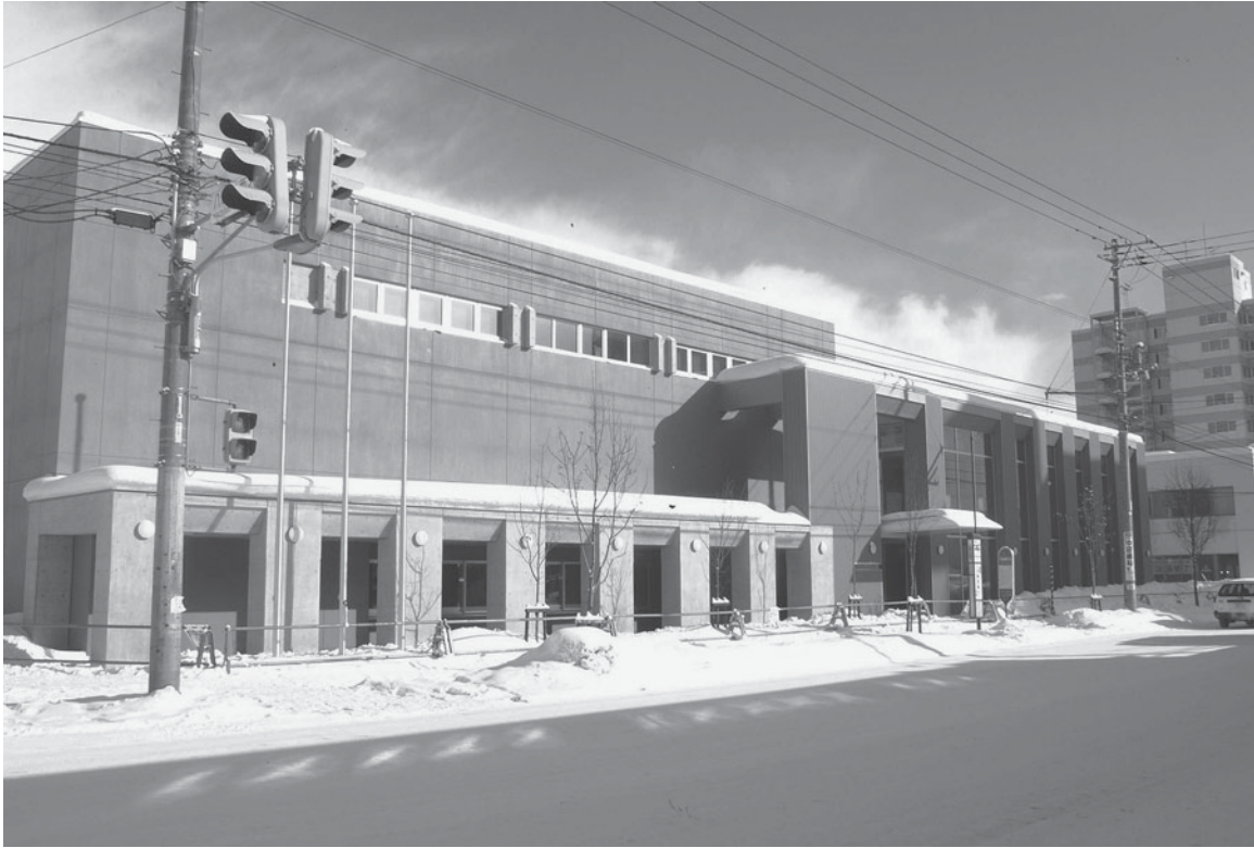
▲下手稲通側からの建物外観
